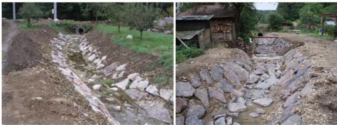
Obr. 32 Úprava koryta po realizaci
