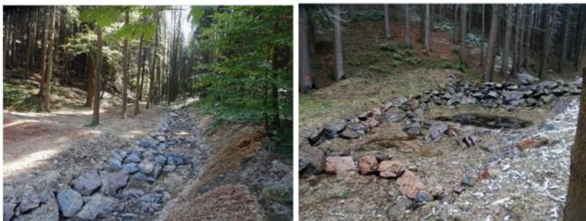
Obr. 30 Místa opatření po realizaci
